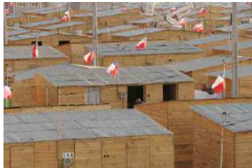
Campamentos de mediaguas construidas tras el terremoto.
